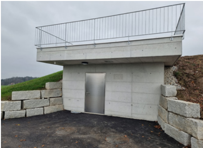
Das Reservoir Rebrain wurde um eine zusätzliche Kammer erweitert.
